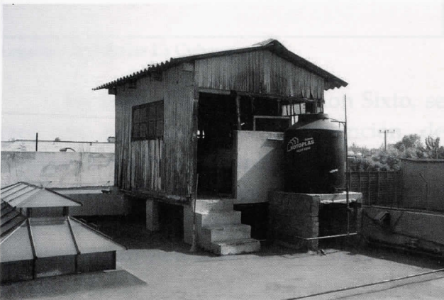
Bodega de la azotea
