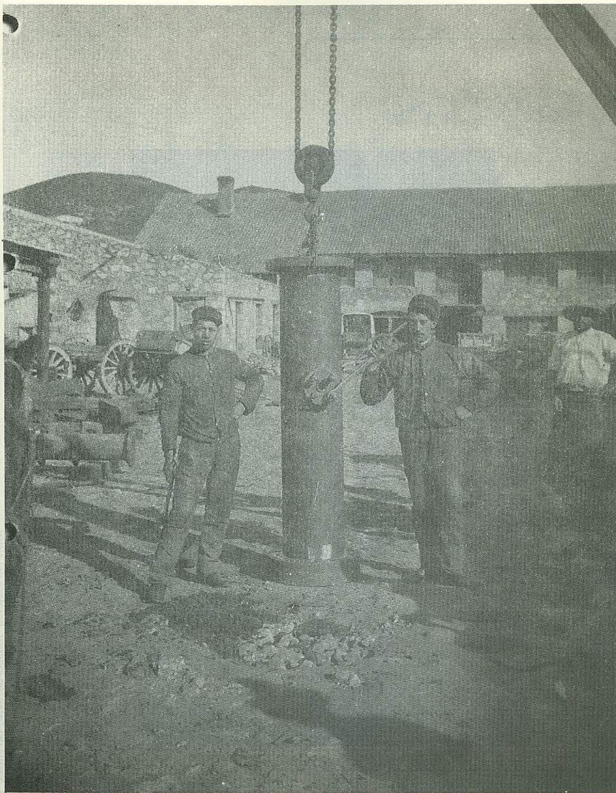
FOTOGRAFÍA 3. Desagüe de la mina La Dificultad-Real del Monte. Tubo roto ya compuesto. Fototeca del AHMM.
